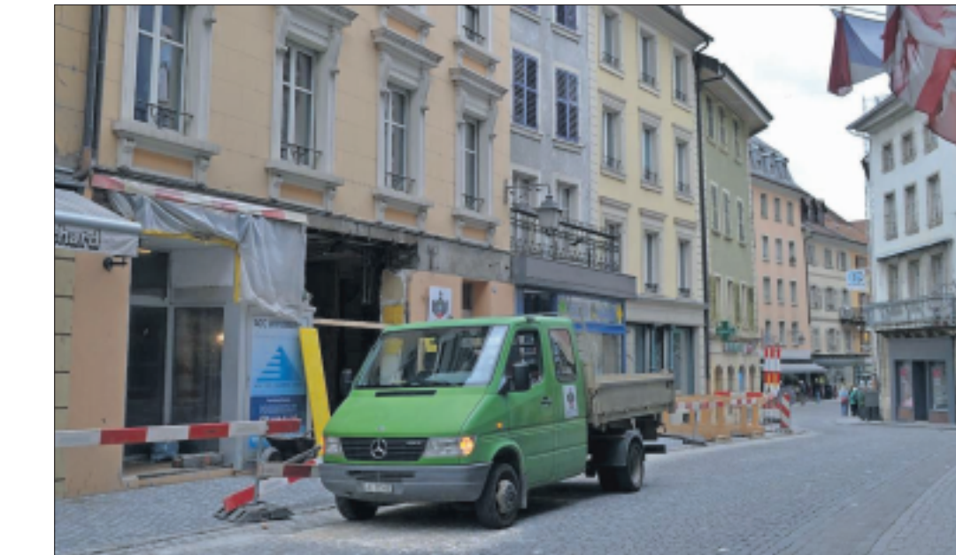
L'immeuble d'Herculis Partners à Porrentruy sera en chantier jusqu'à l'été prochain pour accueillir un guichet de change et une salle de coffres-forts.
